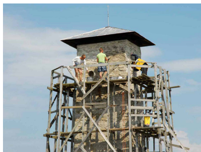
Restaurering av kapellet
